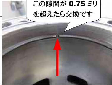
・ピストンリング合い口隙間確認
